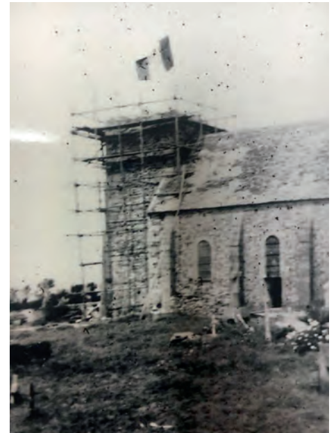
➔ Photographie appartenant à Mme Pain montrant le clocher de Siouville démonté à l'aide d'un échafaudage.
